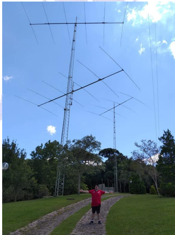
Imagem: Martin Butera (PT2ZDX), dando as boas-vindas ao impressionante campo de antenas da estação ZW5B
