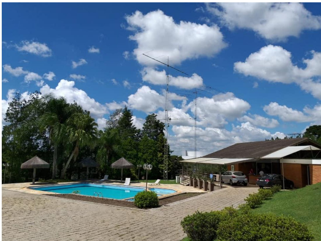
Imagem: podemos ver a torre com antenas de banda de 15 metros 8 sobre 8 empilhadas, Lança de 18 metros, com torre de 24 metros de altura. (projeto W2PV) e ao fundo à direita a antena Steppir
