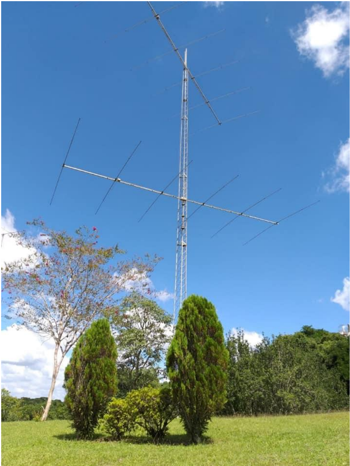
Imagem:: Antenas para banda de 20 metros, 6 em 6 empilhadas, Lança de 20 metros de comprimento, torre autoelevatória de 30 metros de altura
