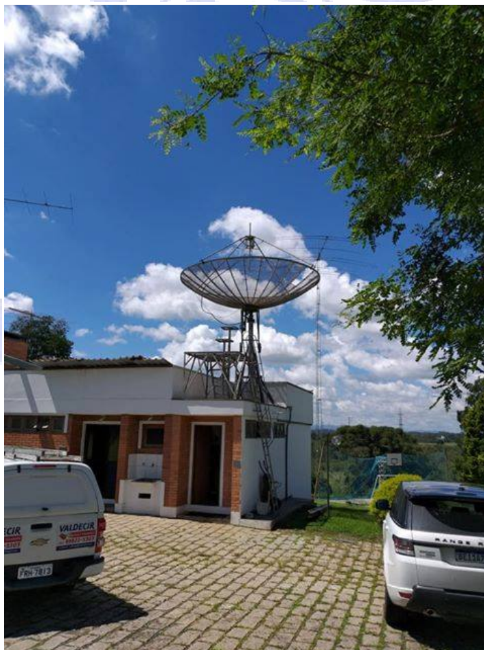
Imagem:: Antena Moon Bounce (Parabólica de 6 metros - EME 144 Mhz)
